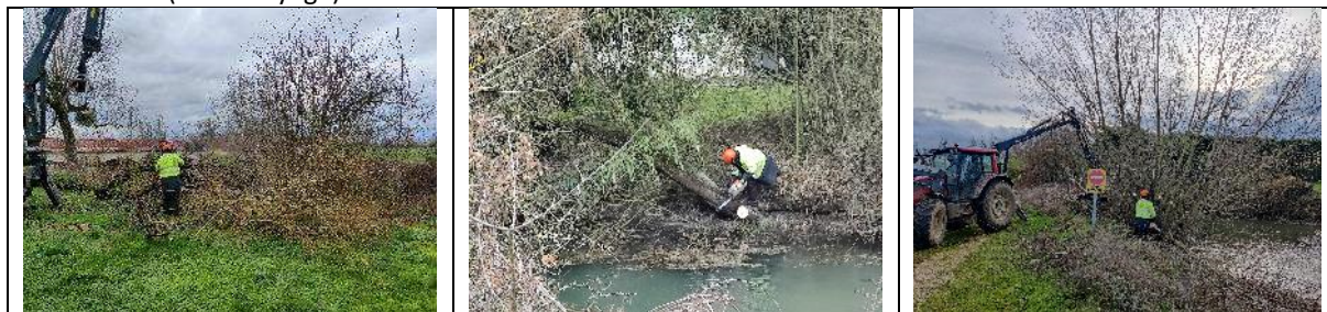
Illustrations des travaux
