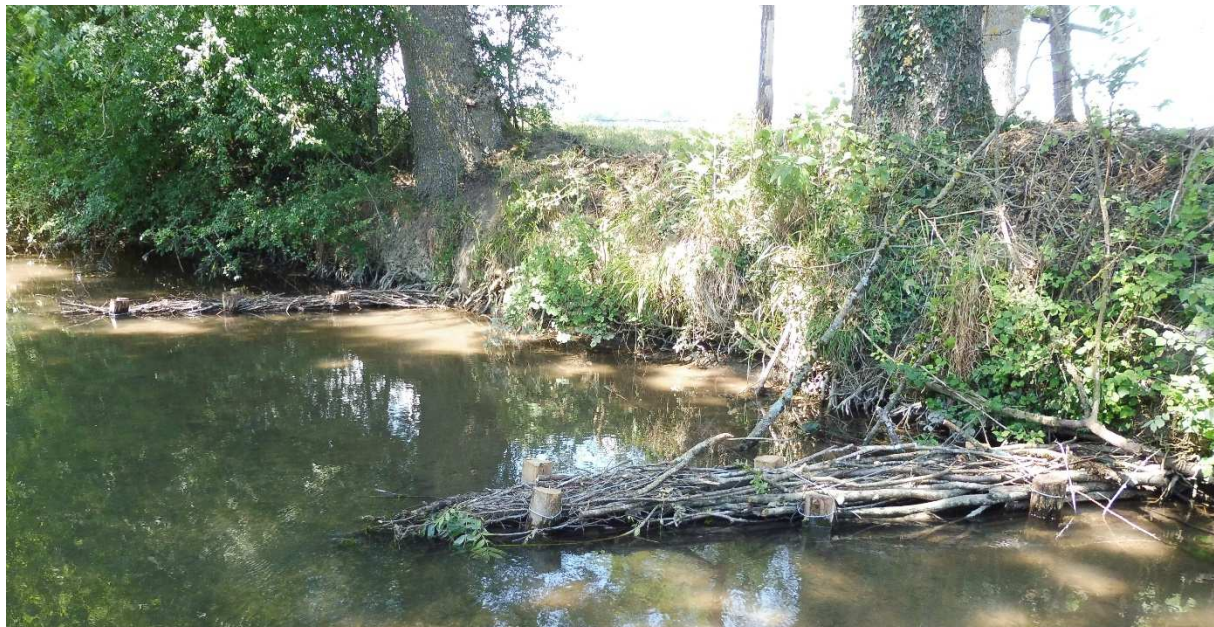
Exemple d'Epis installés en juin 2020
