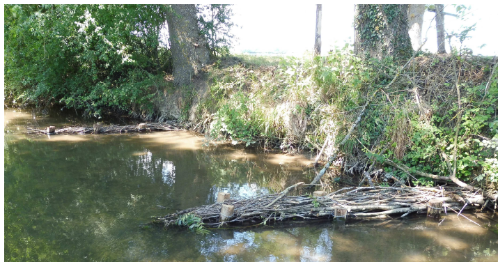
Epis installés en juin 2020
