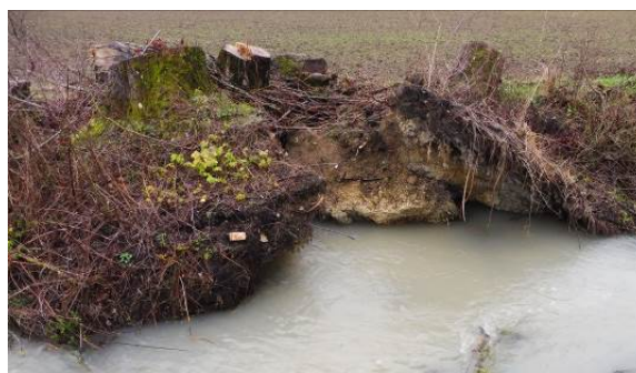
Berge après intervention (septembre 2019)
