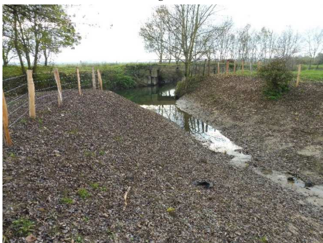
L'accès à la confluence Mordain-Vouge sécurisé
