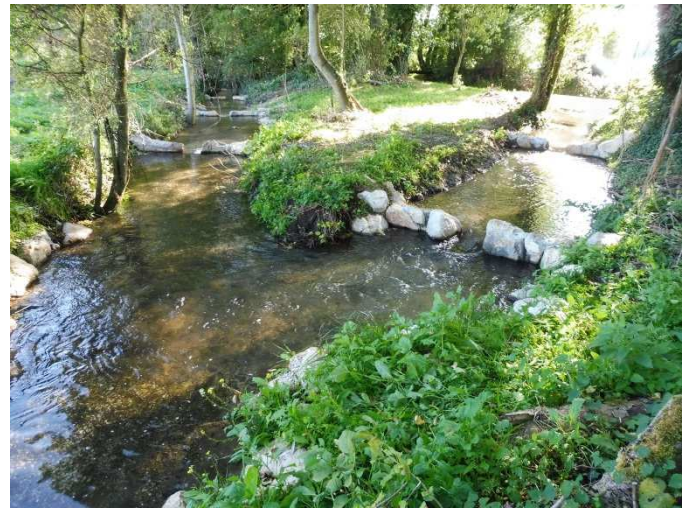
La rivière de contournement et ses seuils
