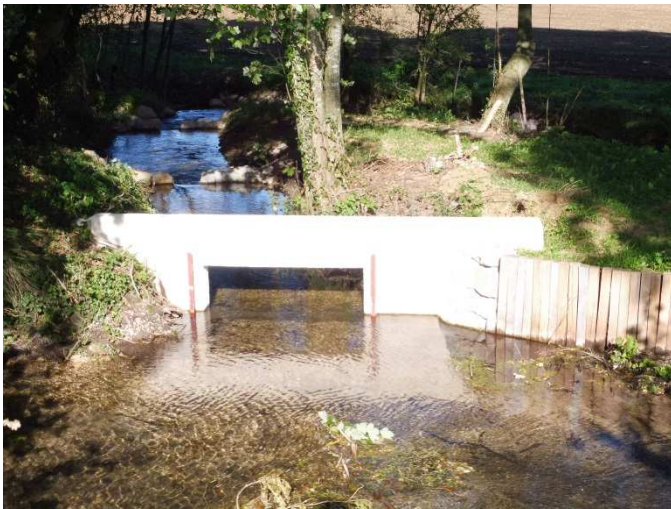
La prise d'eau de la rivière de contournement
